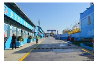
钢板路循环使用
