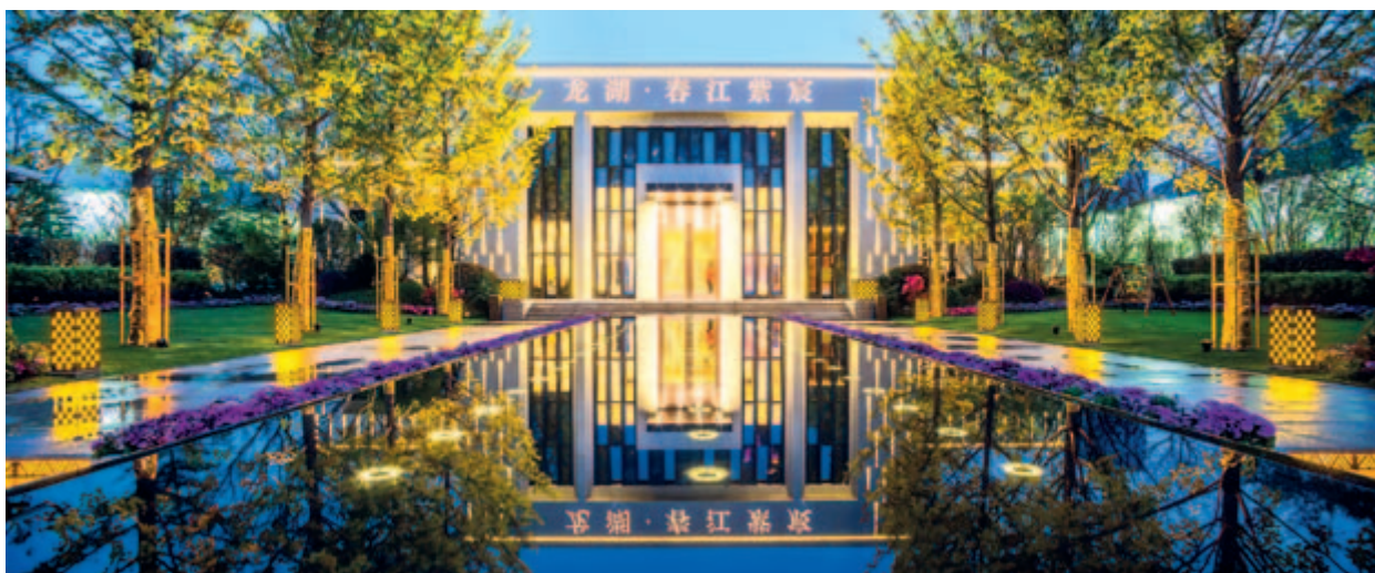
南京春江紫宸 Nanjing Chunjiang Center
