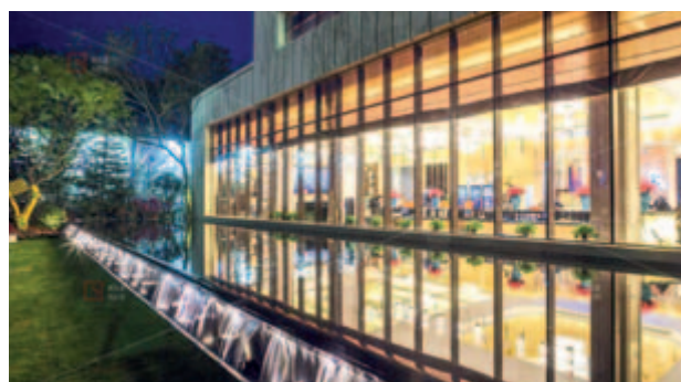
南京春江紫宸 Nanjing Chunjiang Center
